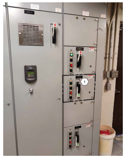
EXISTING MCC-AA SPARE SCALE: NTS
